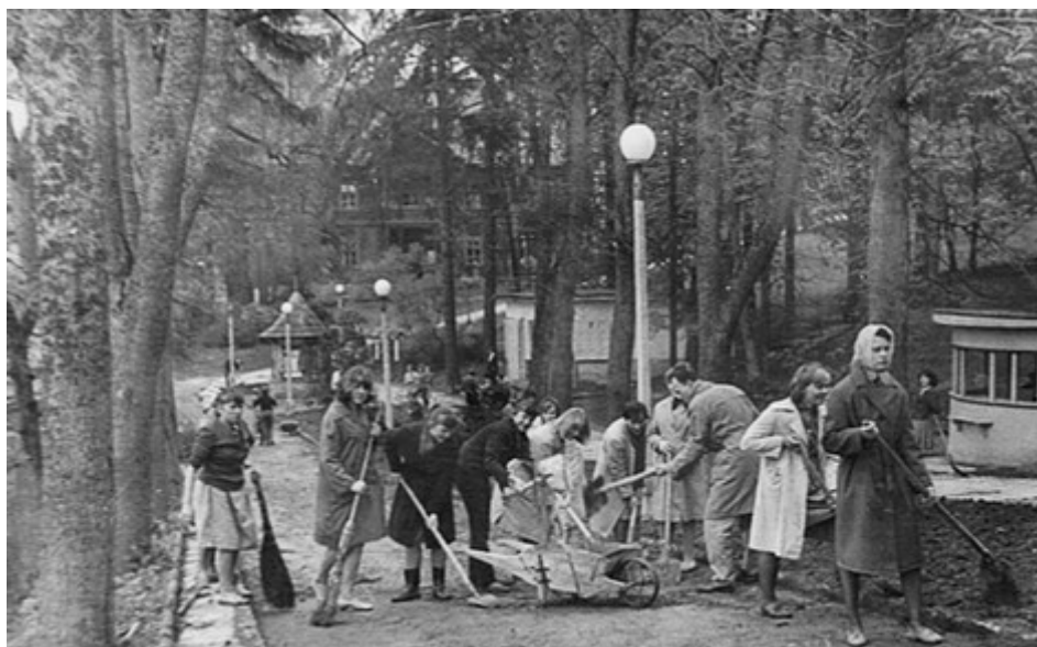
Prace remontowe na deptaku (archiwum K. Ceklarz)
