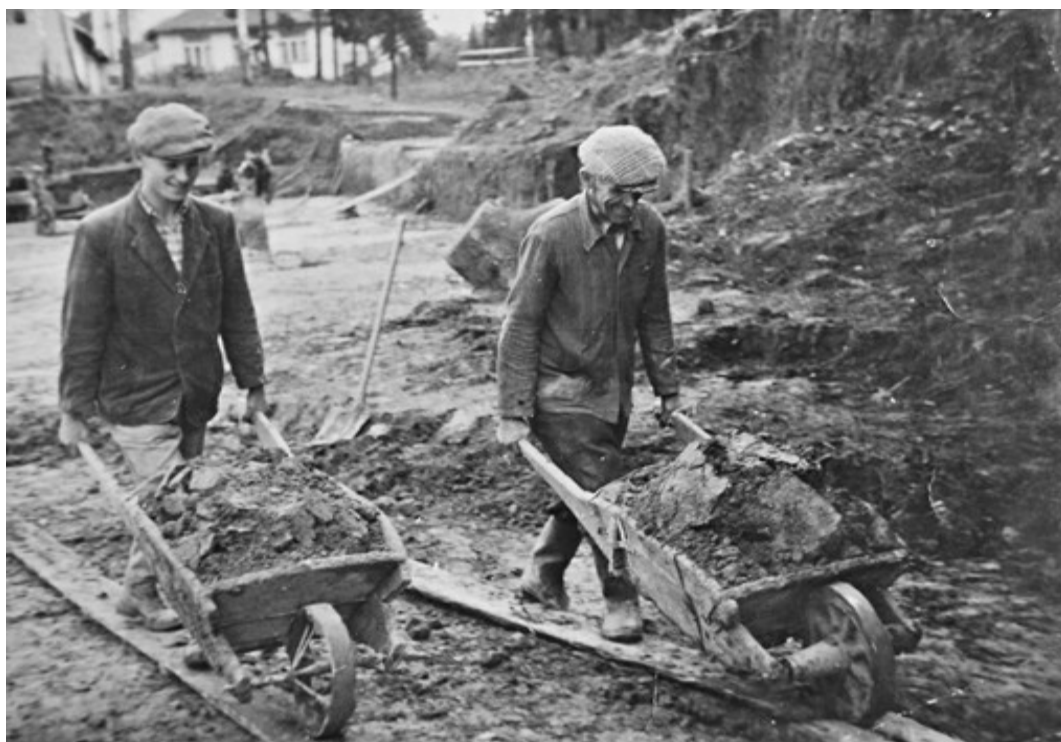
Prace przy rozbudowie stadionu w 1959 r. (archiwum J. Cieplińskiego)
